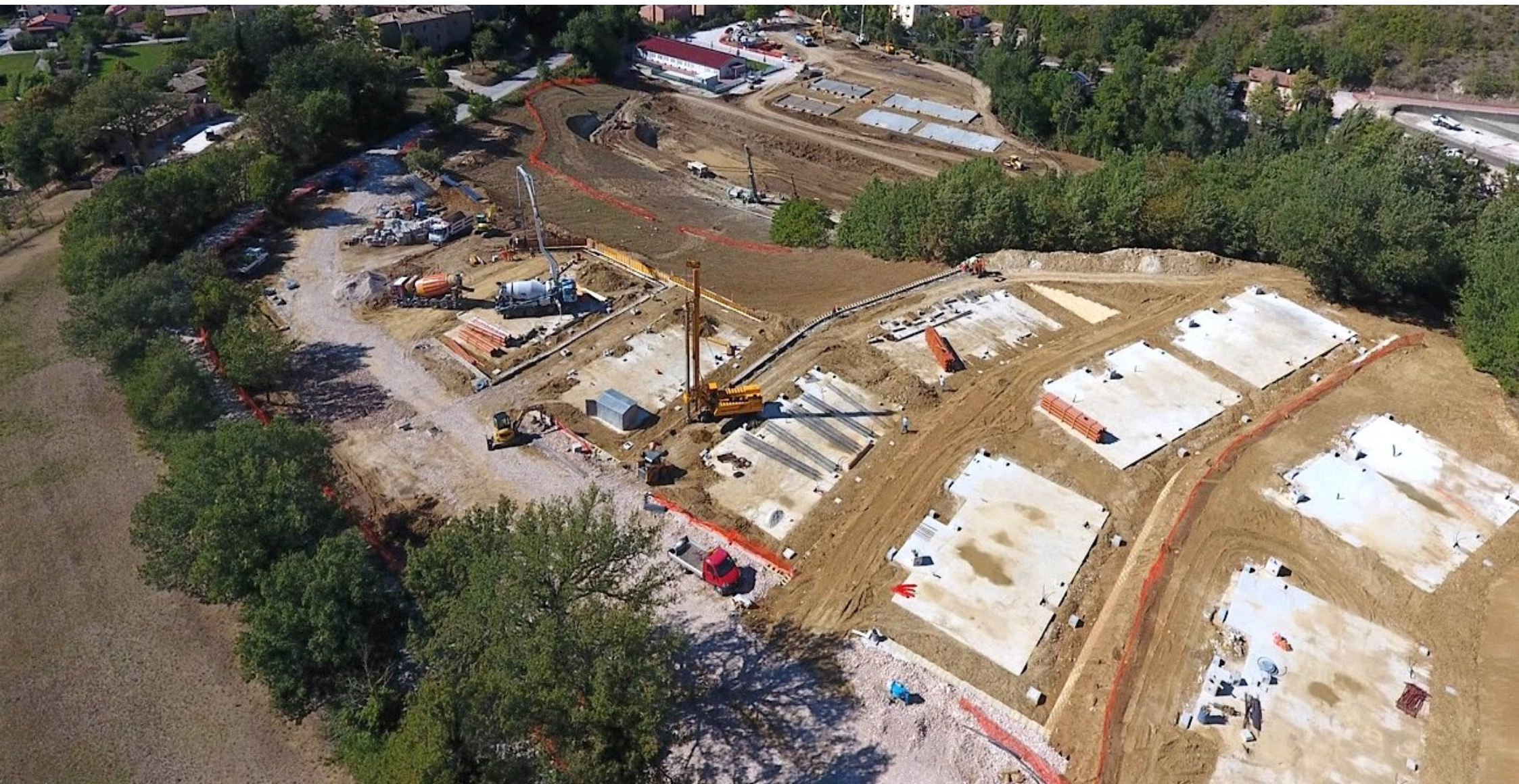
Cantiere area SAE con in evidenza le fondazioni delle abitazioni temporanee, 2017.
